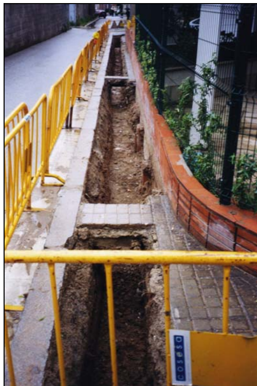
F2: Vista parcial de la rasa oberta al carrer Dr. Ibáñez
