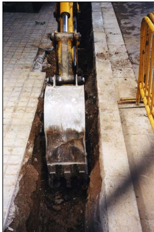
F1: Inici de la rasa al carrer Dr. Ibáñez cantonada amb carrer d'Europa amb retro-excavadora.
