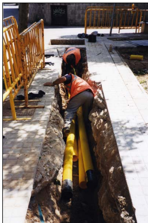
F4: Col·locació del cablejat a la rasa del carrer de can Segalar
